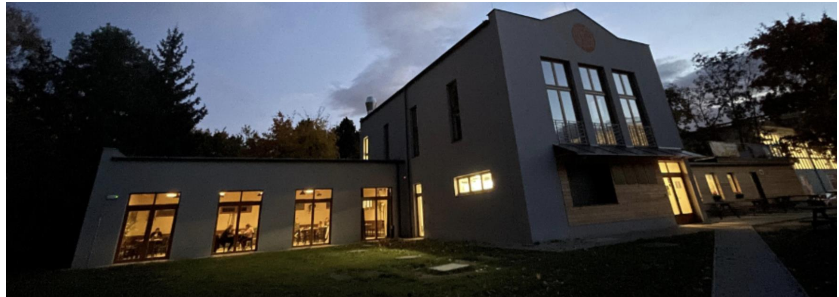
Hlavní budova areálu
